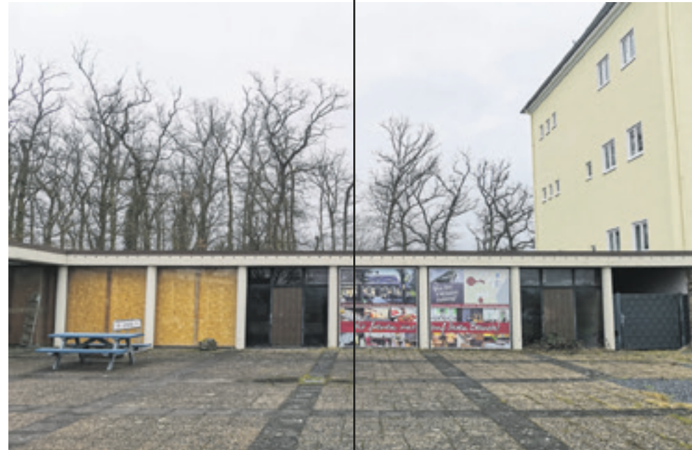
Im Außenbereich findet sich ein ungenutzter Zwischengang, der St. Paul Wittlich und die benachbarte Senior:innenresidenz verbindet. Gemeinsam mit deren Bewohner:innen soll ein Teil der audiovisuellen Installation gestaltet werden.
